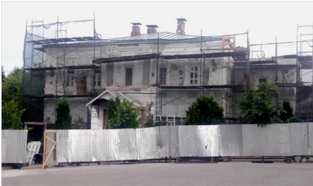
Капитальный ремонт игуменского корпуса
